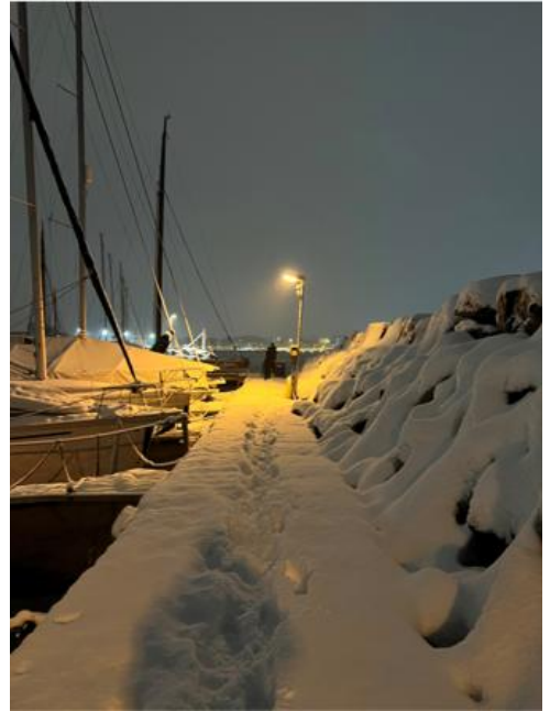
Eksempel på belysning av pir ved Søly båthavn. Lave master er ikke blendende. Master er rettet mot kai og lyset skjermes fra sjøen av en steinkant. Varm lyskilde gir god atmosfære. Lyskilden gir en del strølys og kunne vært bedre avblendet.
