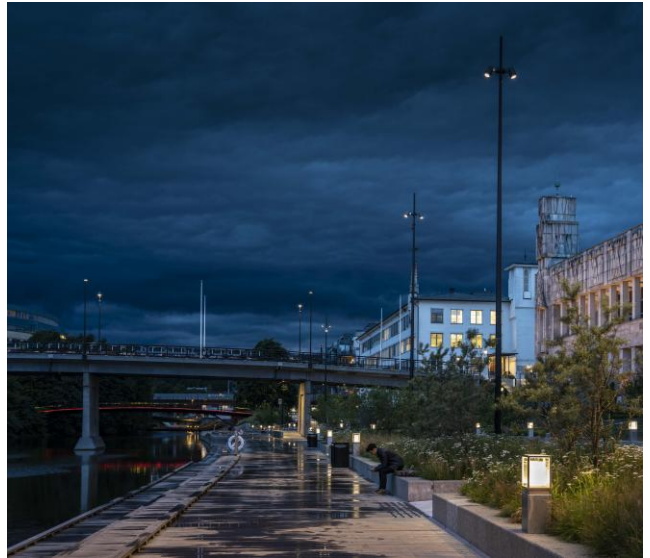
Eksempel på belysning av gangsti ved Sandvika elvepromenade. Tekniske armaturer på mast gir funksjonslys på gangvei. Lave dekorative lamper skaper atmosfære og glød langs promenaden. Dekorative lamper har svak og varm lyskilde.
